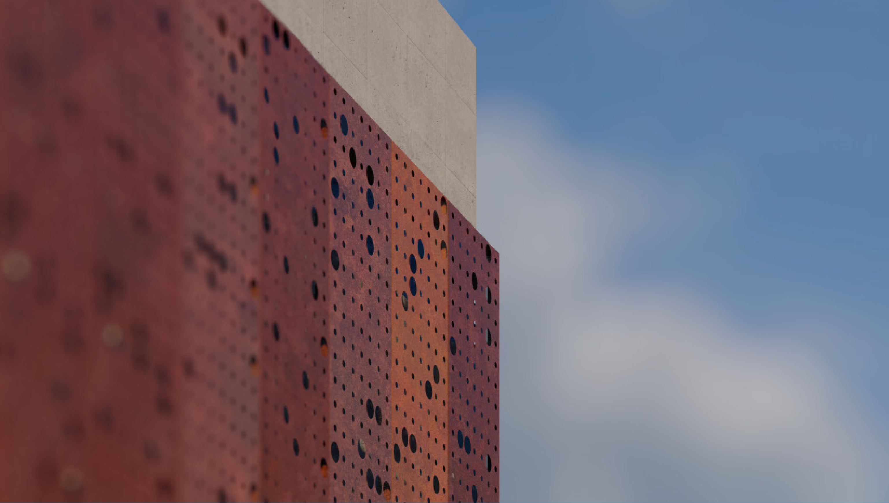
Figura 5.28- Imagem ilustrativa do detalhe da Placa Perfurada Hunter Douglas Screenpanel XL.Fonte: Autoria própria.
