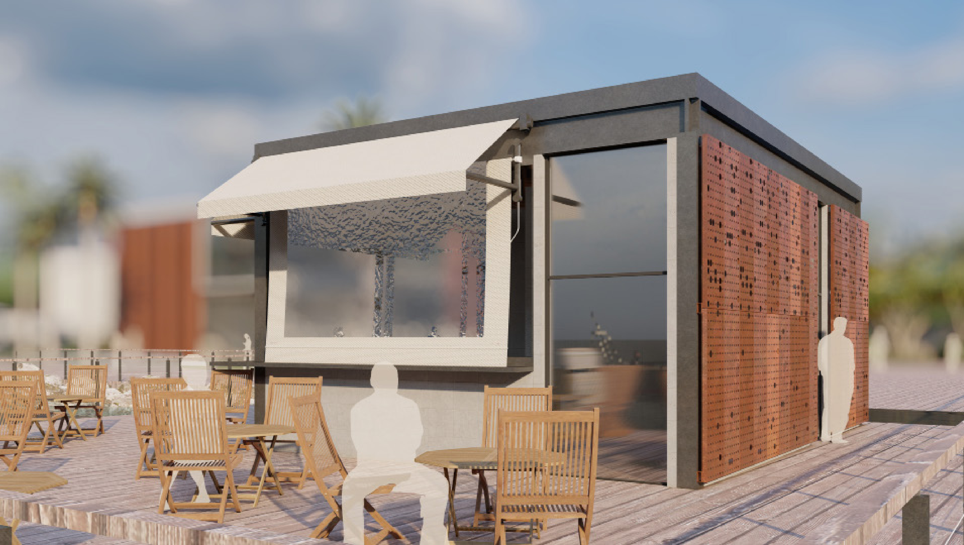
Figura 5.29 - Detalhe da Placa Perfurada Hunter Douglas Screenpanel XL no Projeto da Fachada da Cafeteria. Fonte: Autoria própria.
